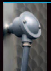
Porte-sonde de contrôle de la température
