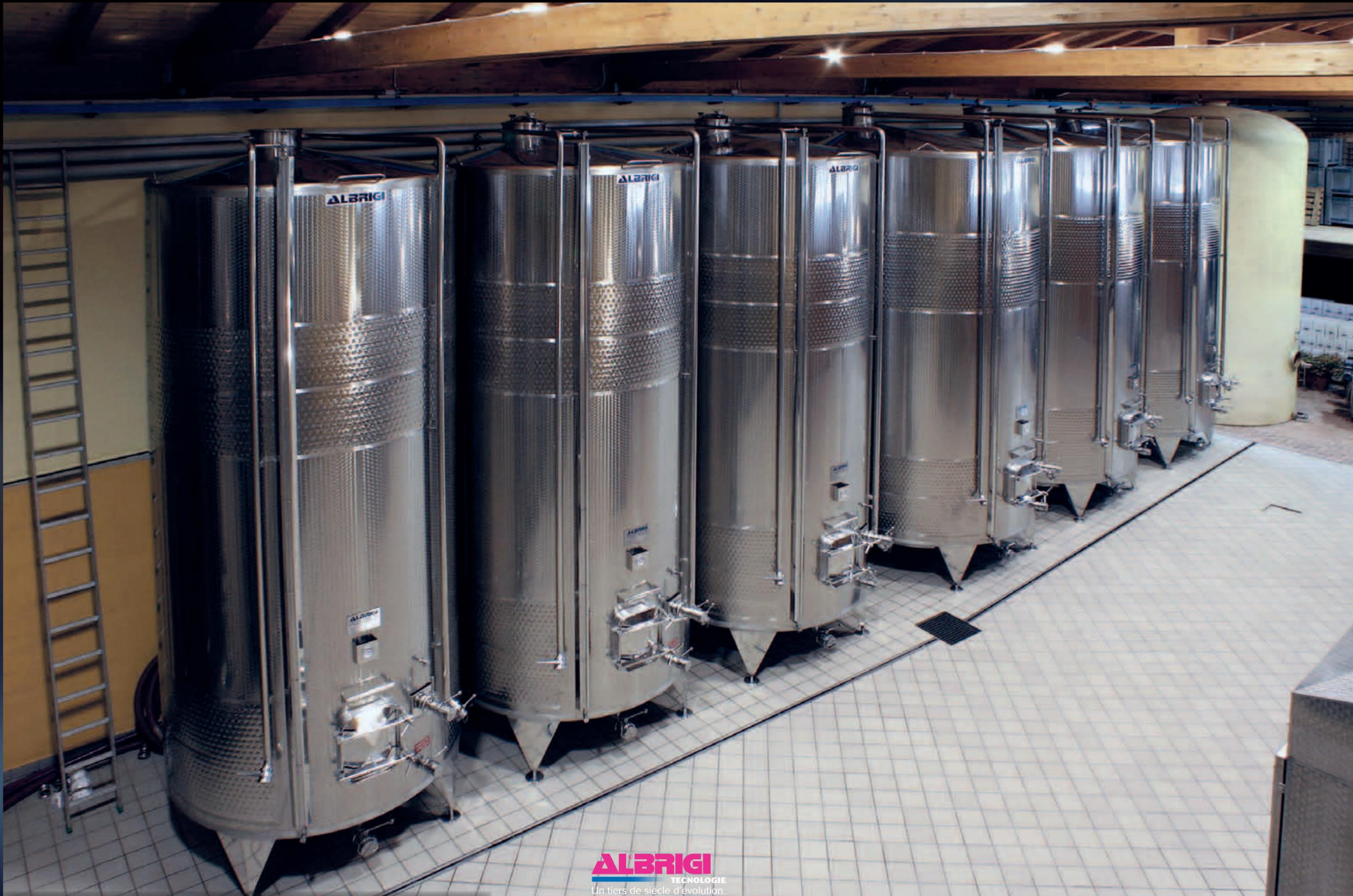
Réservoirs Vinotank de 150 hl thermoconditionnés avec Termostar Double et installation de lavage Cleanfix
