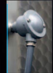
Porte-sonde de contrôle de la température
