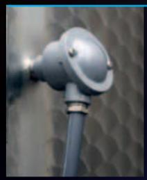
Porte-sonde de contrôle de la température
