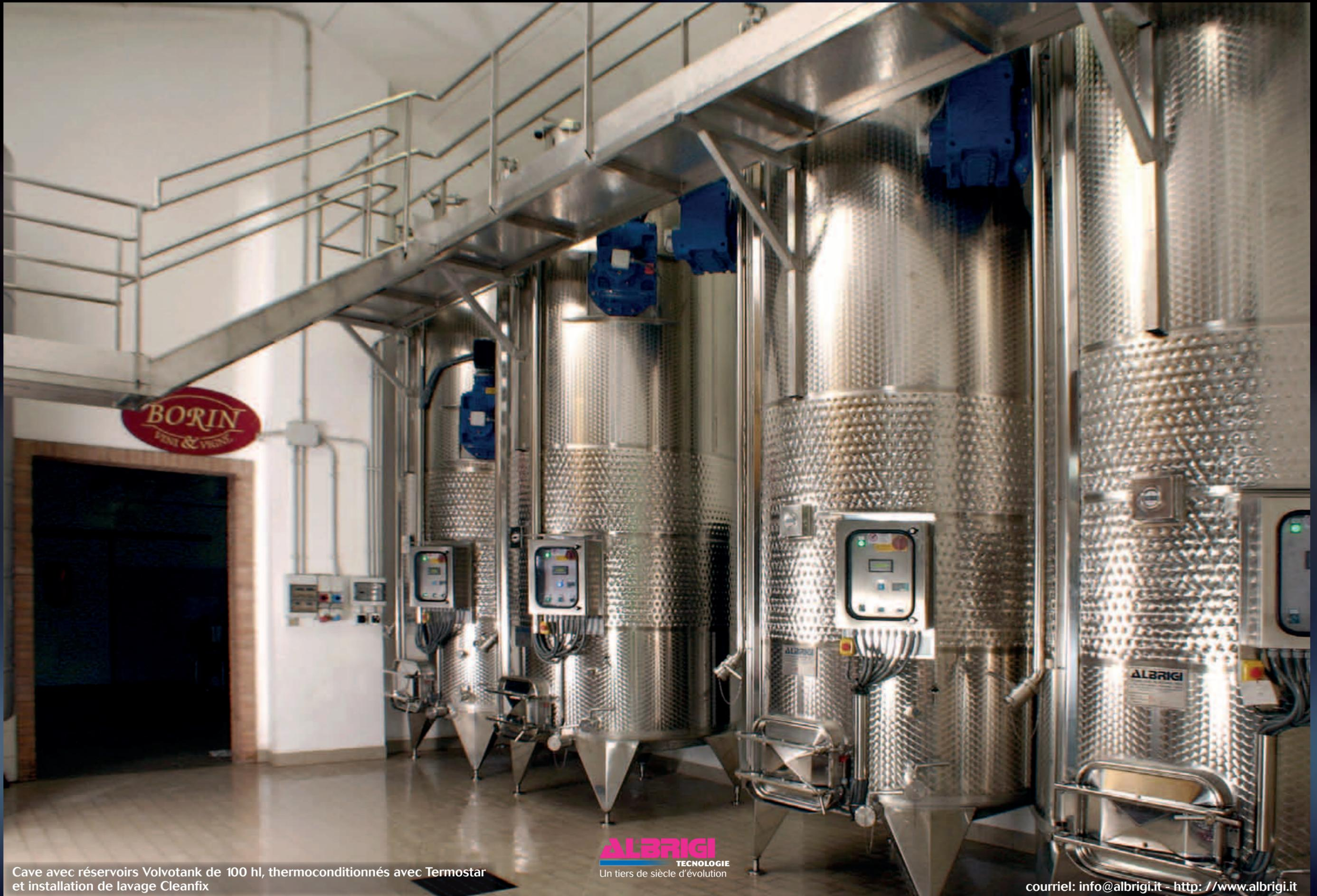
Cave avec réservoirs Volvotank de 100 hl, thermoconditionnés avec Termostar et installation de lavage Cleanfix
