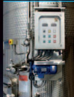
Tableau électrique de gestion de la pompe de remontage ou des phases de pigeage
