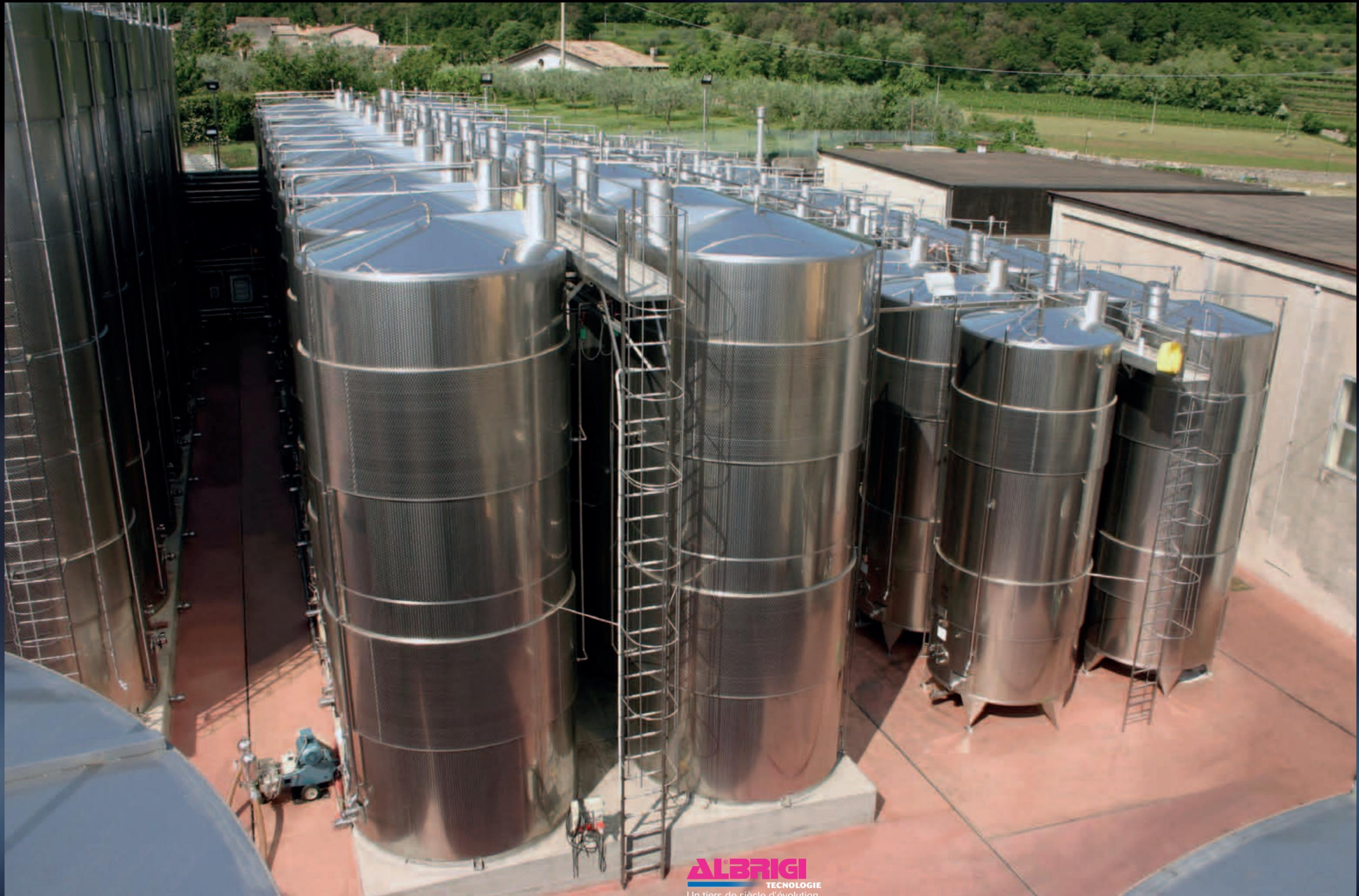
Réservoirs Megatank de 600 hl et 300 hl thermoconditionnés avec Termostar Double, isolés avec Isoplus et installation de lavage Cleanfix
