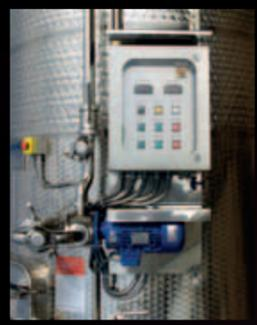
Tableau électrique de gestion de la pompe de remontage et des phases de pigeage
