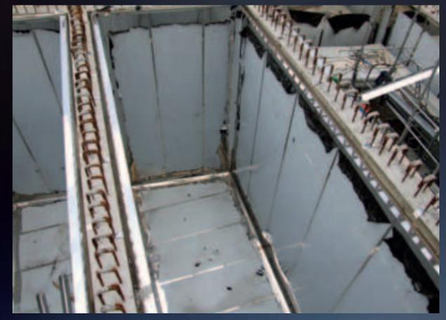
Voûte montée et armée, prête à être coulée avec du béton
