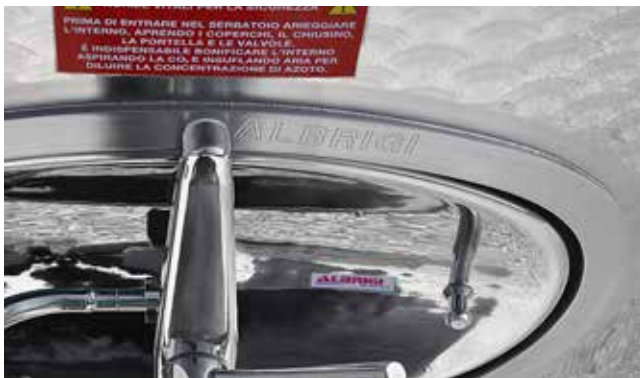
External oval manual TIG welding of hatch Saldatura a TIG manuale su portella ovale all'esterno
