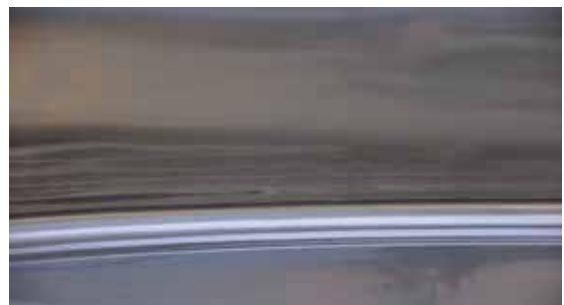
Saldatura, Tig/Plasma circolare interna del bordo del fondo, rullata e lucidata a specchio
