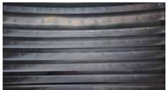
Interno lucido di intercapedine "Termostar", nella zona della trapuntatura, viene rilucidata la lamiera
