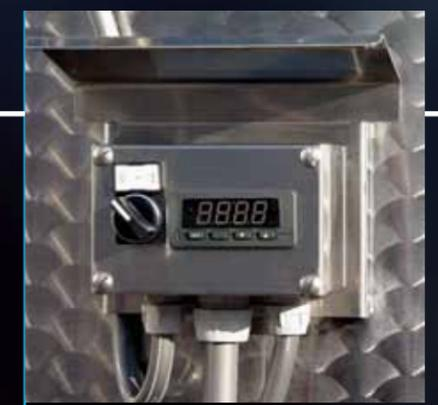
Termostato digitale con il tettuccio di protezione
